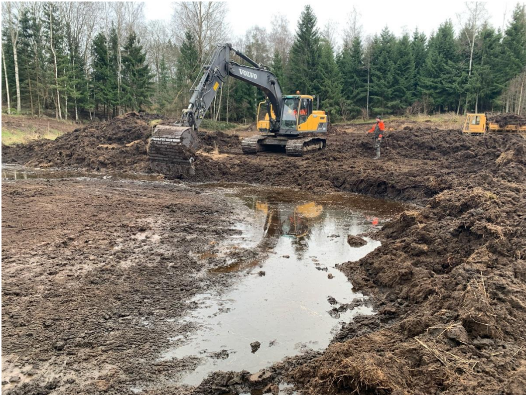
Figur 2: Pågående schakt i NO delen, fyllnadsyta i bakkant till höger och anslutande tidigare använt körstråk som förstärkts i bakkant till vänster. Närmast till vänster i bild har ett grundområde med krön kring 162.15 lämnats (jämför omslagsfoto där vattnet precis står över grundområdet).
