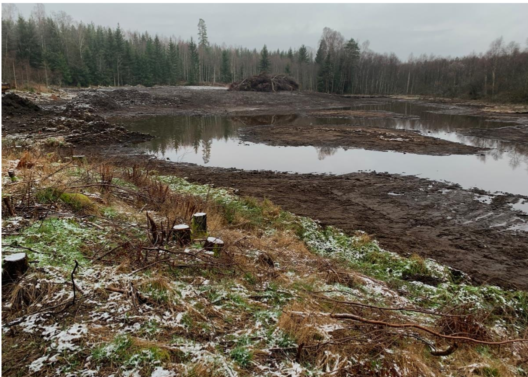
Figur 4: Östra delen med nästan färdig dammschakt och högre vattenstånd. Två grundområden skapade. Anslutning mot fyllnadsyta ej färdigt. Inloppsdel ej utförd.
