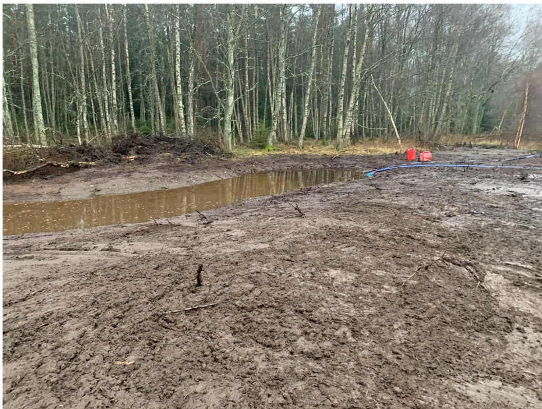
Figur 5: Inloppsdel i väster. Schakthantering lokalt med fyllnad på västra sidan (bildens förgrund och till höger).
