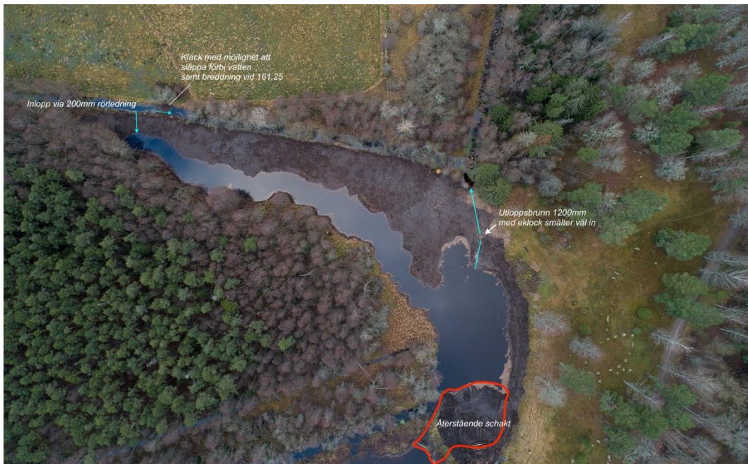
Figur 6: Västra våtmarksdelen med utlöpsbrunn och röranslutningar markerade samt återstående schakt (foto från 23 december 2020).
