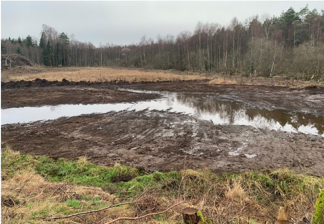
Figur 3: Pågående schakt i NO delen, från höjden/körstråket i norr. Rishögen till vänster i borte delen av bilden. Det norra grundområdet precis färdigschaktat i vänstra halvan av bilden. Befintligt dike lämnat intakt utmed denna del (inlopp framschaktat senare i borte delen av fotot).
